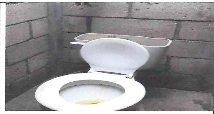
Foto 6: Sanitarios con filtración de agua y desechos fisiológicos
